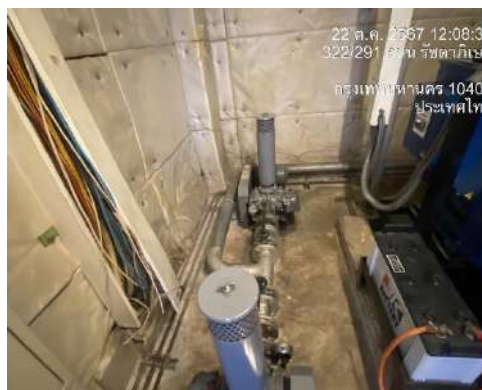
เครื่องเติมอากาศอาคาร B
