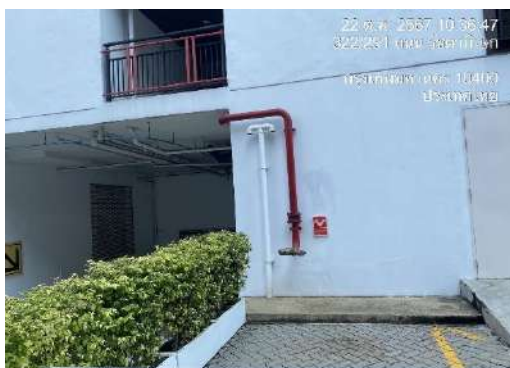
หัวรับน้ำดับเพลิงอาคาร A และ B และท่ออื่น
