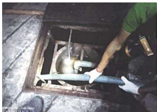
เจ้าหน้าที่สูบล้างในในระบบบำบัดน้ำเสีย
