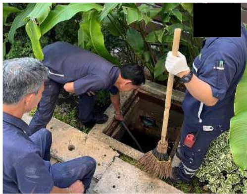
ภาพที่ 2.2-32 เจ้าหน้าที่ตรวจสอบและขุดลอกตะกอนในบ่อหน่วงน้ำ
