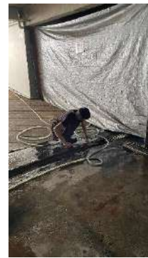
ภาพที่ 2.2-7 รางระบายน้ำและเจ้าหน้าที่ลอกท่อระบายน้ำ
