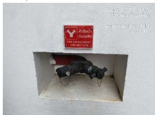
หัวรับน้ำดับเพลิงอาคาร A และ B และท่ออื่น
