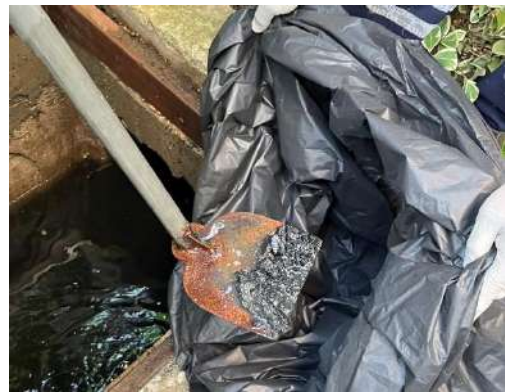
ภาพที่ 2.2-32 เจ้าหน้าที่ตรวจสอบและขุดลอกตะกอนในบ่อหน่วงน้ำ
